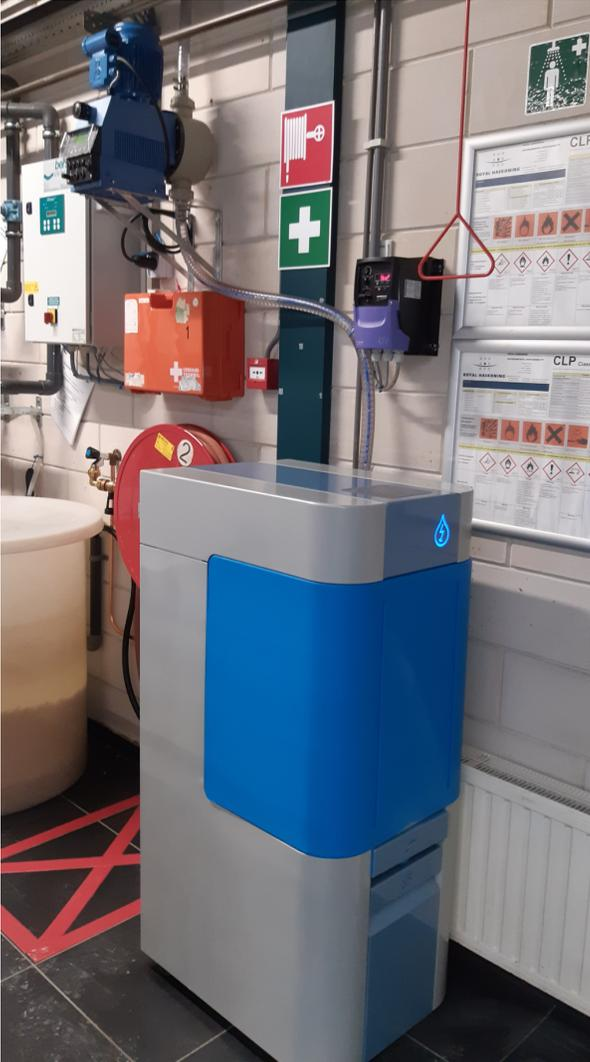
**Kontinuierliche Wasserdeseinfektion:** Die Anlage wird über eine oder mehrere Dosierpumpe(n) an das Prozesswasser angeschlossen. Dadurch wird eine kontinuierliche, geringe Dosierung des Desinfektionsmittels zum Wasser gewährleistet, wodurch eventuell vorhandener Biofilm zunächst entfernt und die Bildung einer neuen Schicht verhindert wird. Garantiert sauberes Wasser ohne zusätzlichen Aufwand.
